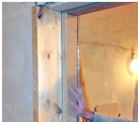
2.zīm. Durvju rāmja nostiprināšana ailē
