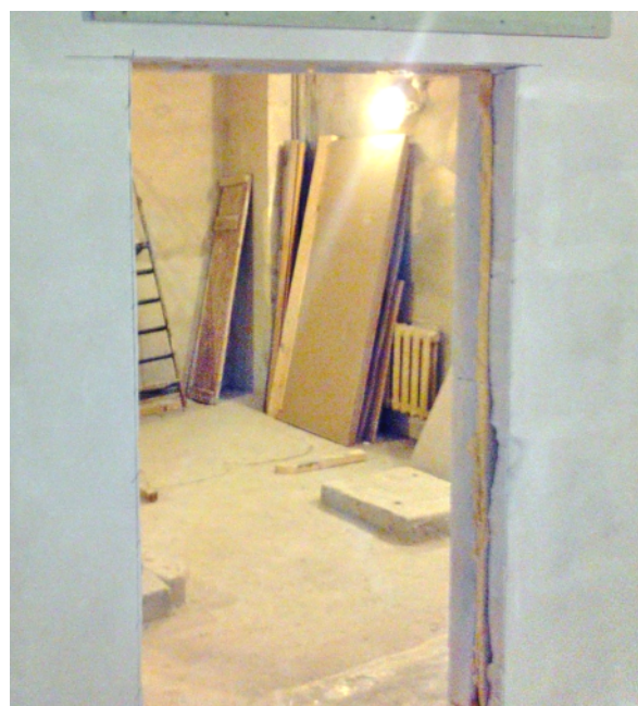
1.zīm. Durvju ailes izveidošana
