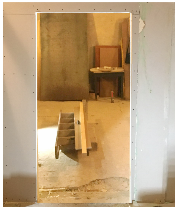
1.zīm. Durvju ailes izveidošana
