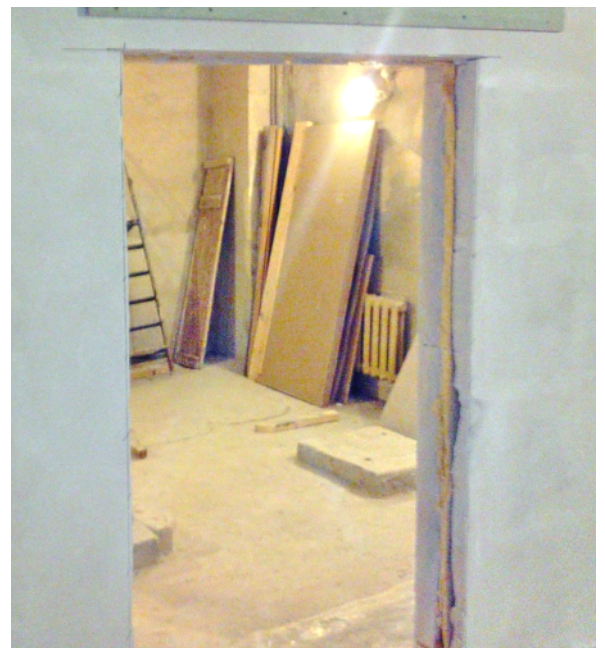
1.zīm. Durvju ailes izveidošana
