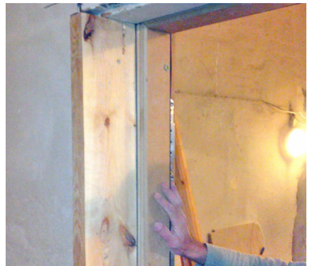
2.zīm. Durvju rāmja nostiprināšana ailē
