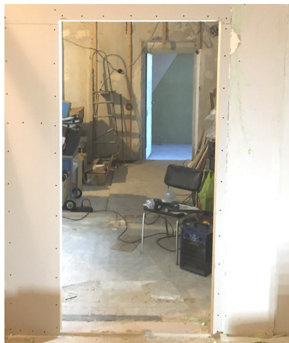
1.zīm. Durvju ailes izveidošana
