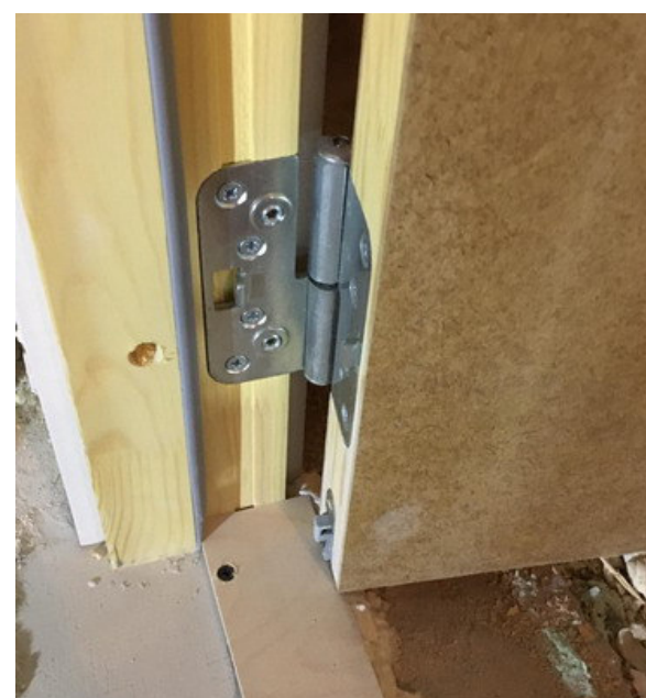
2.zīm. Durvju rāmja un vērtnes nostiprināšana ailē
